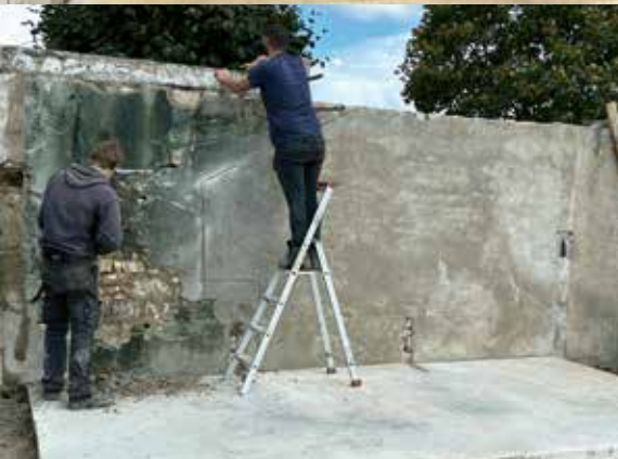
Travaux au nouveau cimetière (octobre 2024)
